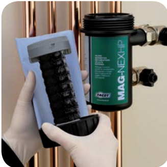
Fig. 5 - Magnete impregnato di fango magnetico
