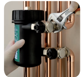
Fig. 3 - Stringere i raccordi a compressione
